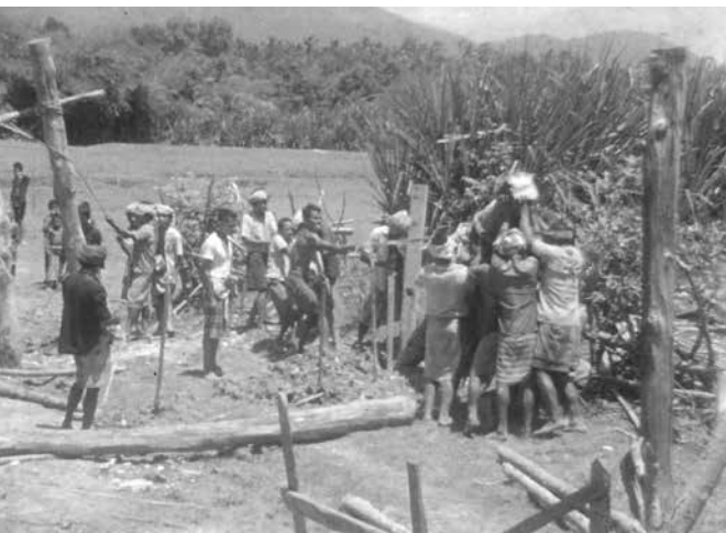
ชาวบ้านช่วยกันสร้างสะพาน
