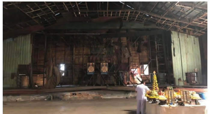
งานบวงสรวงในวันครบรอบ 100 ปี โรงหนังนางเลิ้ง ก่อนการบูรณะ
